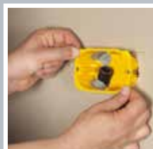
Introduzca la caja en el orificio
