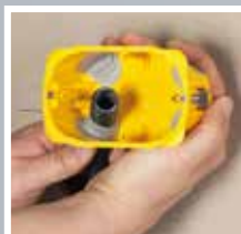
Inserte los conductos
